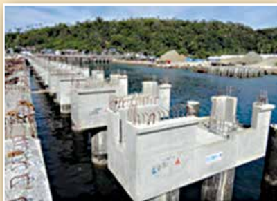
PRECAST PILE CAP
