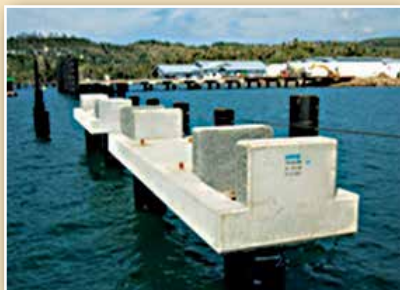
PRECAST PILE CAP
